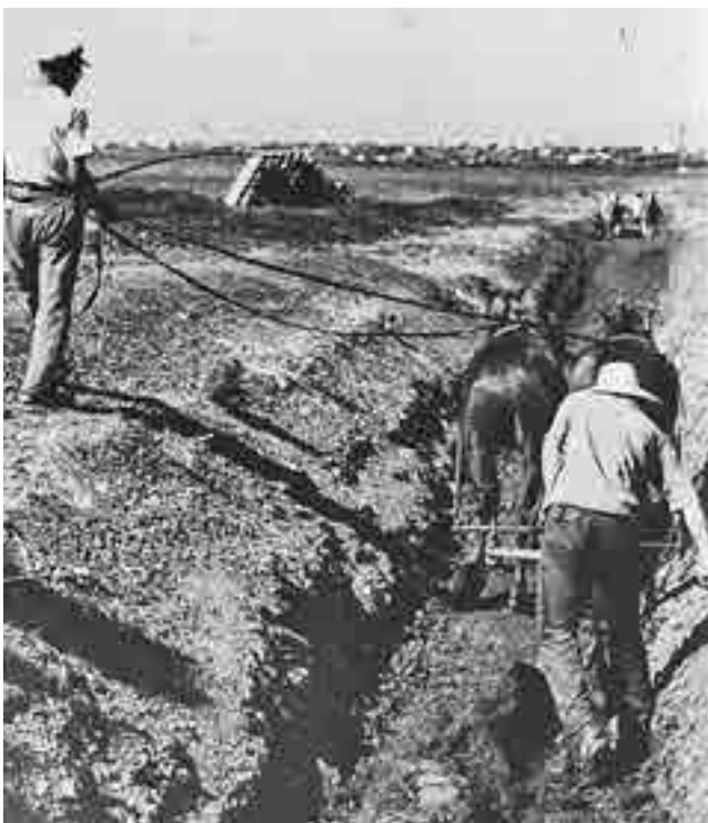
איור 3. חפירת תעלות ראשיות להנחת צינורות מים. באדיבות ארכיון כפר ויתקין וגדעון חרובי
